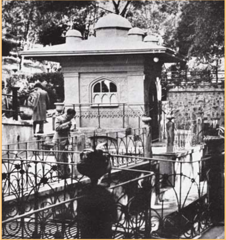
Ana su kaynağı üzerine inşa edilmiş su yapısı (sebil)
