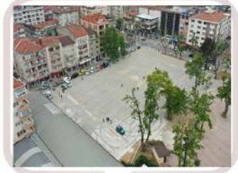
Belediye Hizmet Binası açık otopark alanı parke döşenmesi
